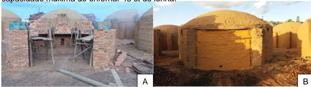
Figura 1 – Ilustração do forno utilizado no processo de carbonização na Fazenda Rio Claro, Arinos – Minas Gerais. A. Construção do forno de alvenaria; B. Vedação da boca do forno após o preenchimento. Fonte: Costa (2021).
