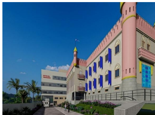
Figura 1. Fachada do “Castelinho”, Jequié, Bahia.
